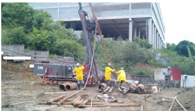
Figura 5 – Colocação da armadura estaca raiz.
