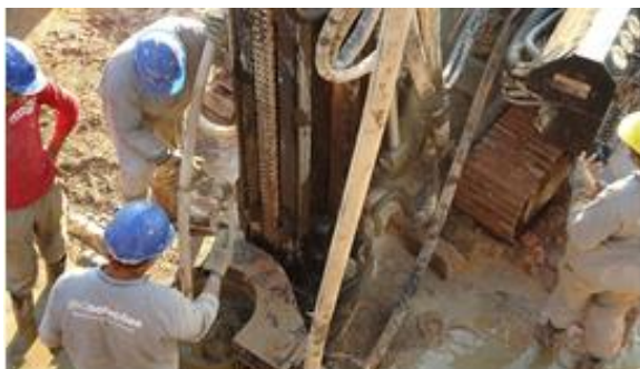
Figura 6 – Injeção de argamassa das estacas testes.
